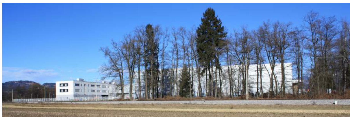
Pogled na obstoječ proizvodno skladiščno poslovni kompleks Filc d.o.o. z jugozahodne strani.
