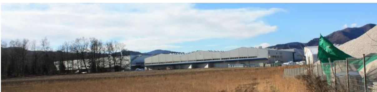
Pogled na obstoječ proizvodno skladiščno poslovni kompleks z vzhodne strani.
