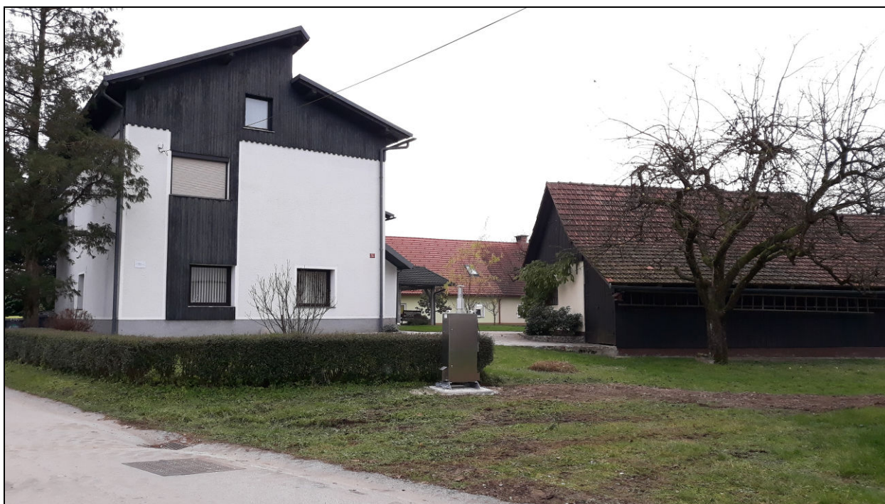
Fotografija 1: Merilno mesto v Godešiču iz severozahodne smeri, levo od merilnika stanovanjska stavba z naslovom Godešič 42. Merilno mesto z dovoljenjem lastnika na parcelni številki 19/10 k.o. Godešič
