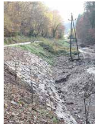
Škarpa na začetku ceste pod Lubnikom. Obrežno zavarovanje med cesto in vodo — zložba kamen, beton.
