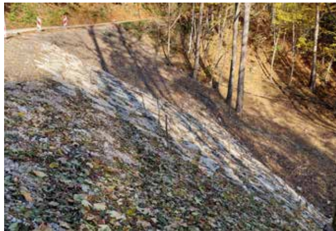
Sanacija usada z drenažo, 500 m 3 skal, s tirnicami in temeljno ploščo
