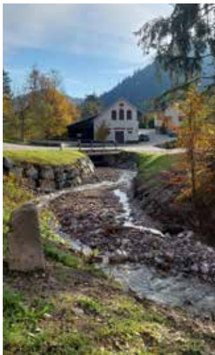
Čiščenje struge na začetku vojaške ceste in zavarovanje s kamnito-betonskim zidom
