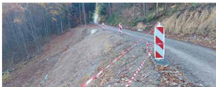
Sanacija usada s kamnom in betonom pod cesto na Sv. Petra Hrib
