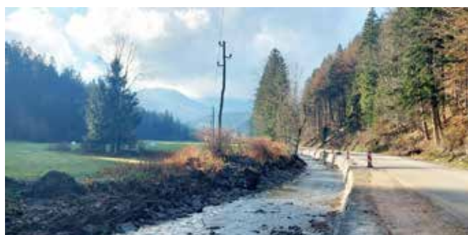
Sanacijska dela v Luši
