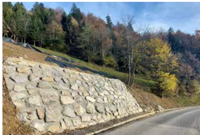
Zavarovanje plazja s travnika s kamnom in betonom
