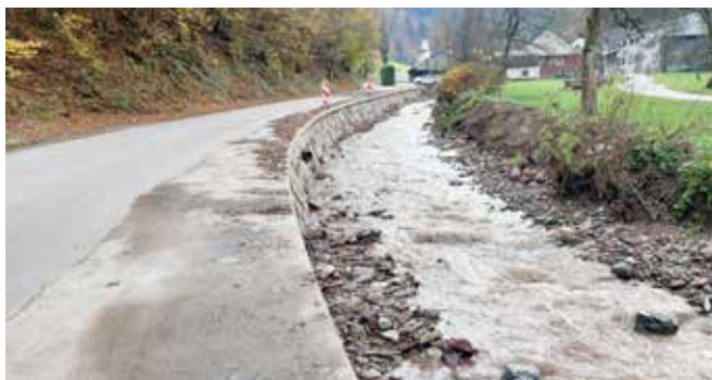
Sanacija v močno poškodovani Bodoveljski grapi
