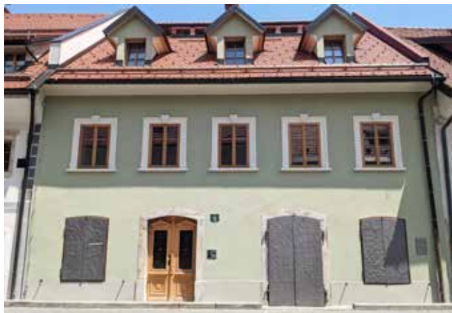
Prenova hiše na Spodnjem trgu 12
