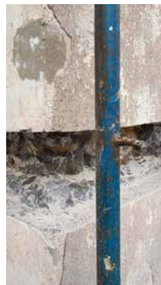
Izdelan poglobljen kanal za namestitev zunanje obodne vezi
