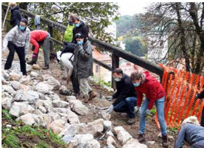
Obnova suhega zidu na vrtu Loškega gradu
