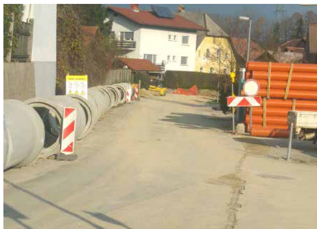
Obnova Ljubljanske ceste in izgradnja zadrževalnika za meteorno vodo
