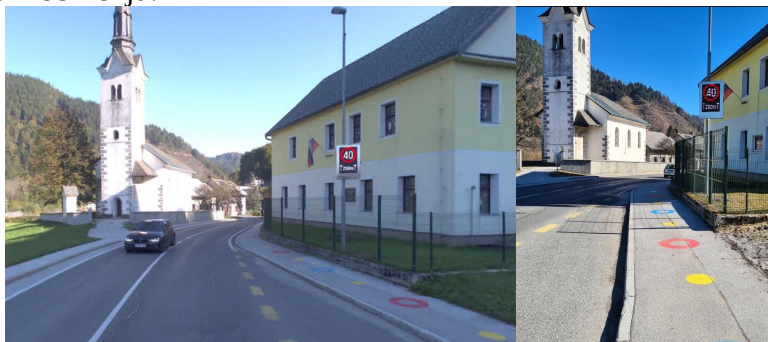
Slika 4 in 5: spremenljiva svetlobna signalizacija in ukrepi na šolski poti.
